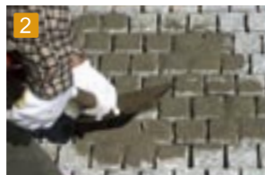
2 目地仕上がりレベルー10mm (歩道仕様)まで砂を入れます。
