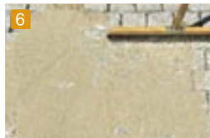
6 目地詰め 合材をブラシ・ホウキ等で 目地に入れ込みます。
