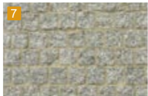
7 完成 硬化時間の目安:施工後24時間
