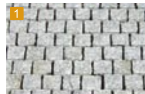
1 下地の調整 目地入れ前
