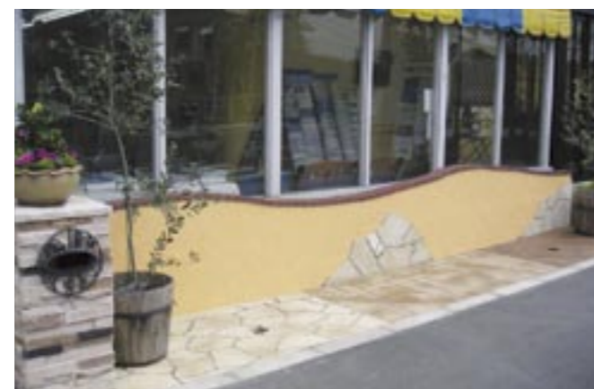
施工後(塗材 MW-221)
