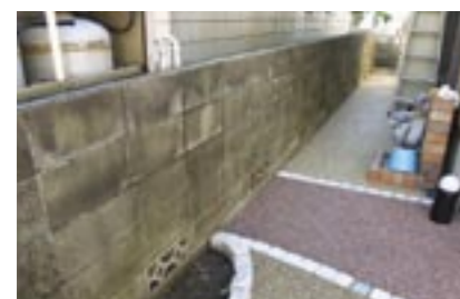
既存ブロック施工前
