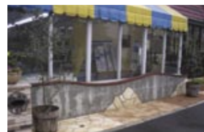
新設下地施工前
