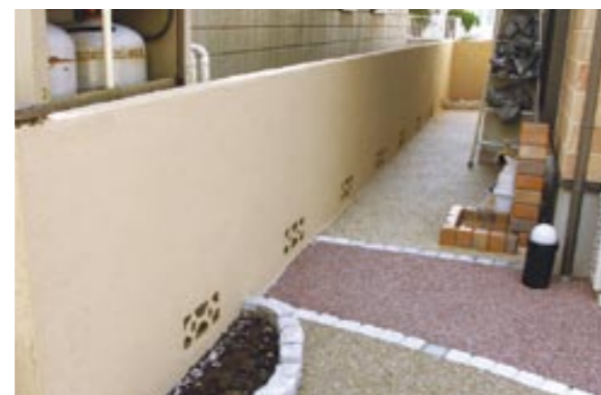
施工後(塗材 MW-242)
