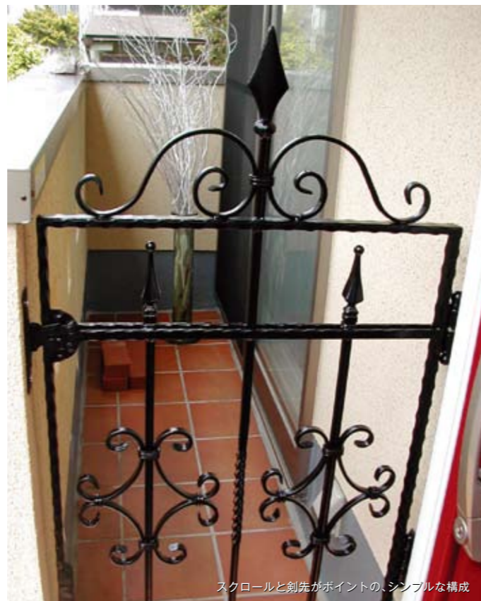
バスケットのバルスターと、スクロールの組み合わせ
