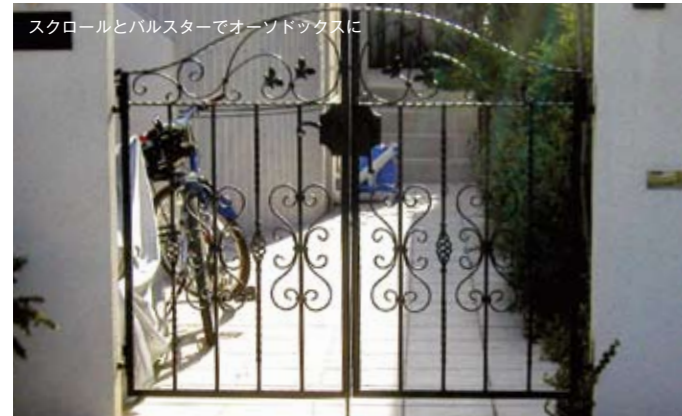
バスケットのバルスターと、スクロールの組み合わせ
