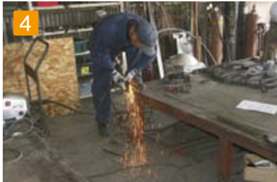
4 アイアンパーツを切断加工します。 納まらないパーツを曲げたり伸ばしたりして調整します。
