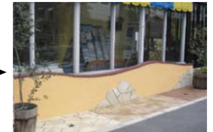
施工後(塗材 MW-221)
