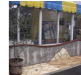
新設下地施工前
