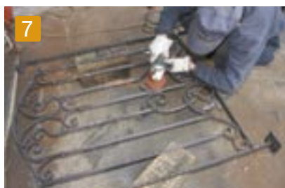
7 溶接した部分をサンダーで荒仕上げします。
