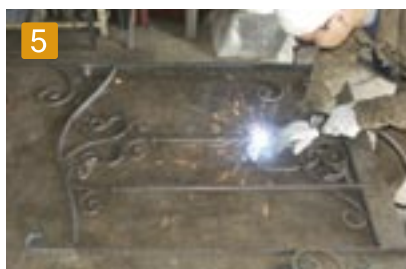
5 外枠材や加工したアイアンパーツを仮溶接します。
