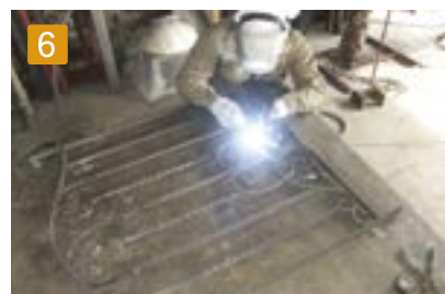
6 寸法等に問題がないか確認してから本溶接します。
