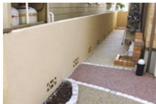
施工後(塗材 MW-242)
