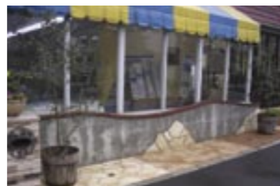
新設下地施工前
