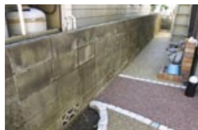
既存ブロック施工前
