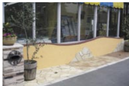
施工後(塗材 MW-221)
