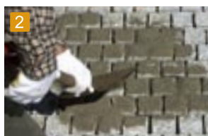
2 目地仕上がりレベルー10mm (歩道仕様)まで砂を入れます。
