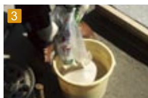
3 合材の作成 砂(珪砂5号)10kgに対し「メジ簡単君」1袋(400g)を入れます。
