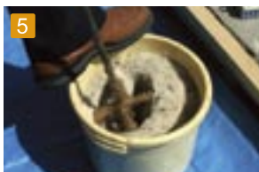
5 ハンドミキサー等で よく攪拌して下さい。
