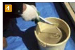
3 合材の作成 砂(珪砂5号)10kgに対し「メジ簡単君」1袋(400g)を入れます。
